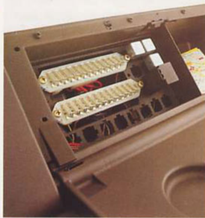
Het zekeringskastje – overzichtelijk en gemakkelijk bereikbaar.
